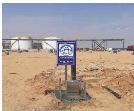
1#地下水监控井 (厂区上游)
