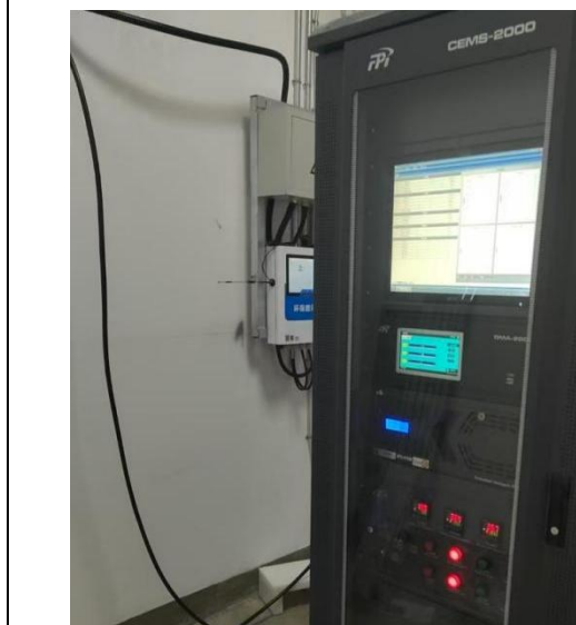
废气在线监测设备开机显示
